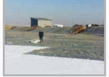
Erzurum Katı Atık Depolama Su Yalıtımı
