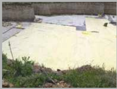
Düzce Yurt İnşaatı
