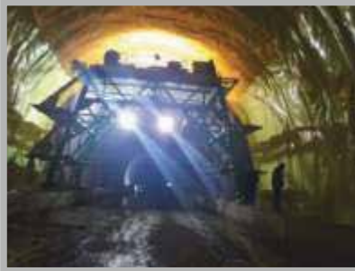
Kığı Yedisu Karayolu Tünel Yalıtımı
